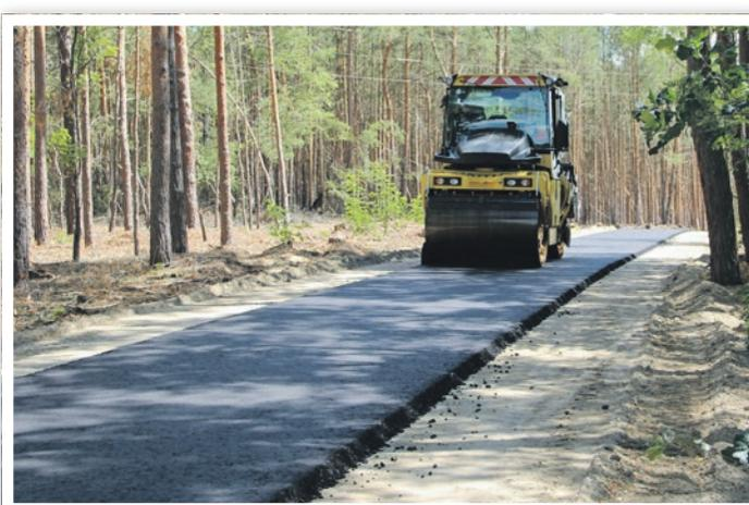
Mit einer Walze wird der Asphalt des neuen Radweges verdichtet.
