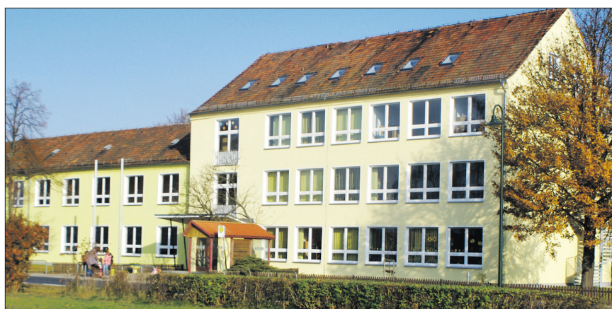
Das Schulgebäude in Züllichendorf
