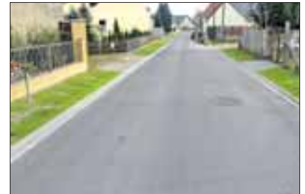
Glatter Asphalt statt unebener Sandweg: die „Bergstraße“ in Ruhlsdorf.
