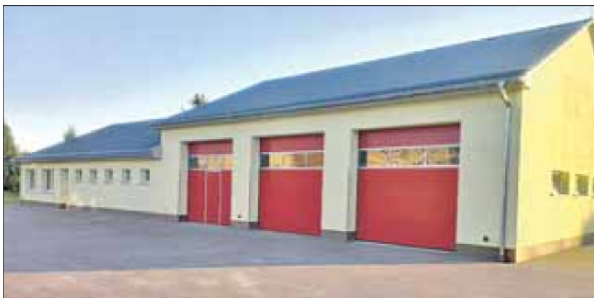
Das neue Feuerwehrgerätehaus in Woltersdorf.
