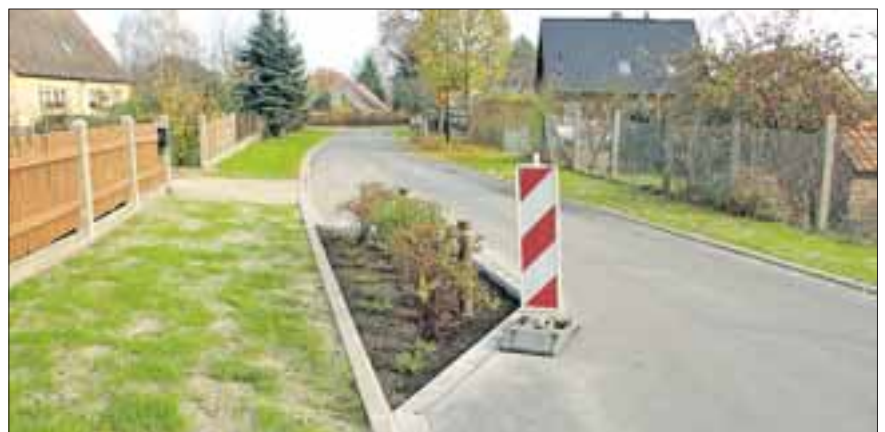
Auch der „Mittelweg“ wurde ausgebaut und ist nun wieder ohne Probleme befahrbar.
