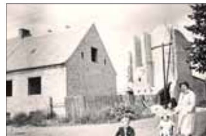
Neubau Haus Rhön mit Speicherruine nach der Zerstörung 1946
